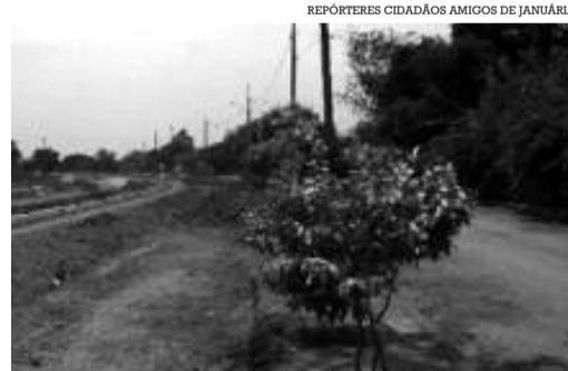
As obras da nova entrada foram paralisadas, deixando apenas terra e barro na frente da casa dos moradores
